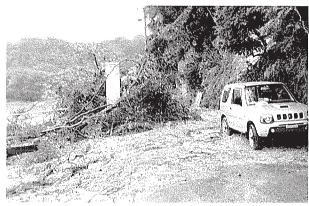
東地区の土砂くずれ現場
